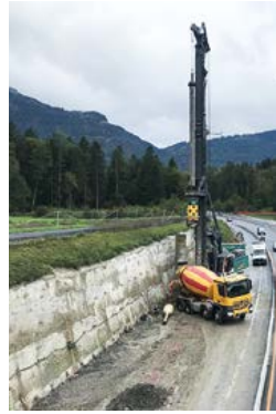
Oktober 2021: Erstellung Ortbetonbohlen
