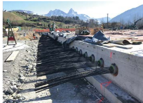
Februar 2022: Überbau Vorspannung
