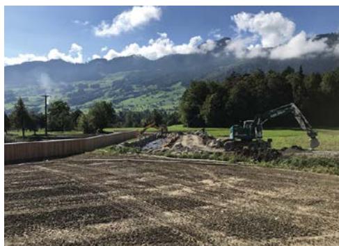
Oktober 2022: Bachlauf Bereich Wildtierüberführung Rötten
