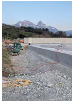
März 2022: Überbau Abdichtung
