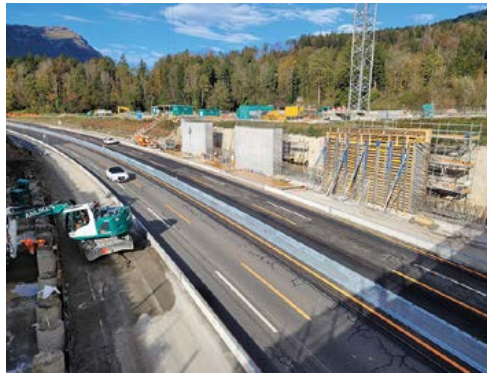
Oktober 2021: Erstellung Fundament und Wände
