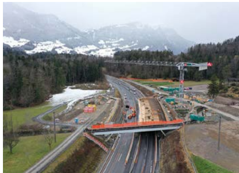
Februar 2022: Übersicht Baustelle Wildtierüberführung Rötten
