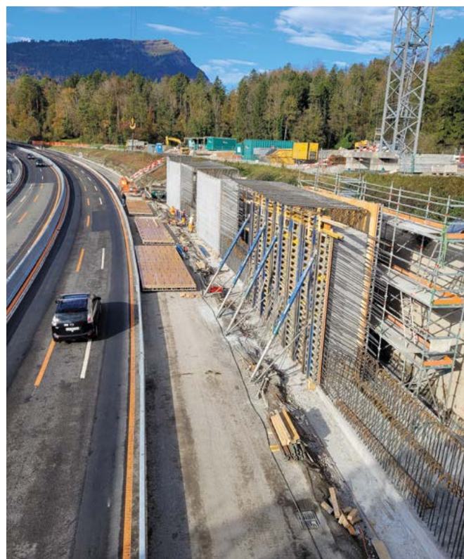
Im Bereich der Wildtierüberführung Röten wurden im vergangenen Oktober beidseitig der Autobahn die Fundamente und Wände für die künftige Passage errichtet.
