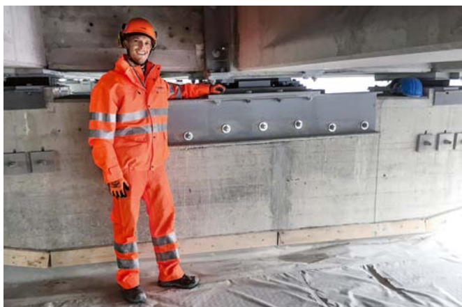
Brücken sind seine Welt: Kevin Möckli, Projektleiter Lager und Fahrbahnübergänge, bei einem soeben eingebauten Brückenlager.
