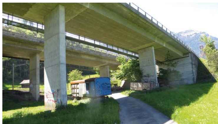
Untersicht Brücke Harmettlen
