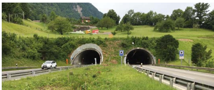
Südportal Tunnel Engberg
