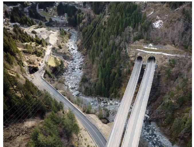
Ebenfalls im Bauprogramm 2021: Ein neuer Belag bei der Dosierstelle Naxberg.
