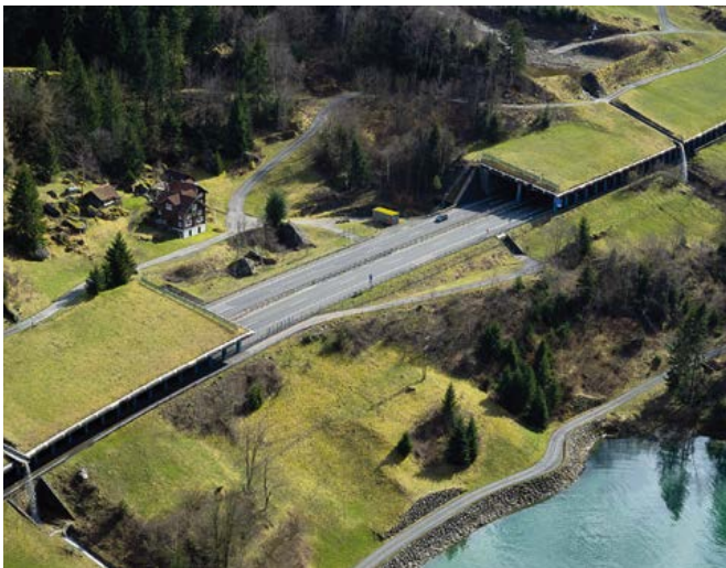
Im Bauprogramm 2021: Eine Lärmschutzwand im Gebiet «Steinen» bei Wassen.
